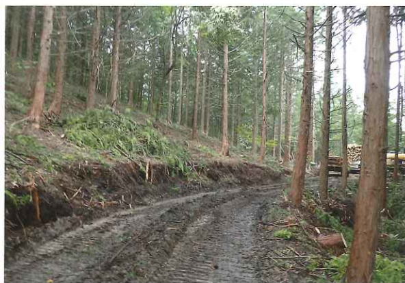
作業道開設（大町市 霊松寺）
