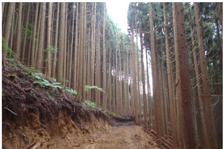
大町市 霊松寺団地 森林作業道開設と搬出間伐
