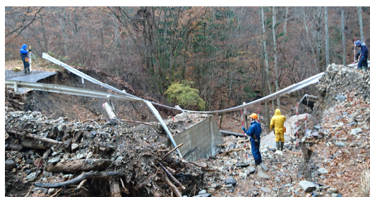
台風 19 号林道災害測量補助業務委託
